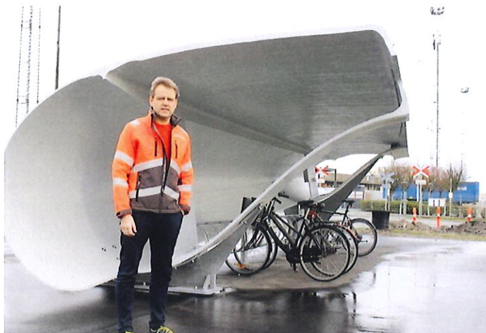
Une pale d'éolienne réutilisée en abri vélo
