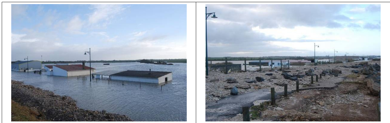
Fig. 12. Submersion des cabanes d'ostréiculteurs et destruction de la digue le 28 février 2010
