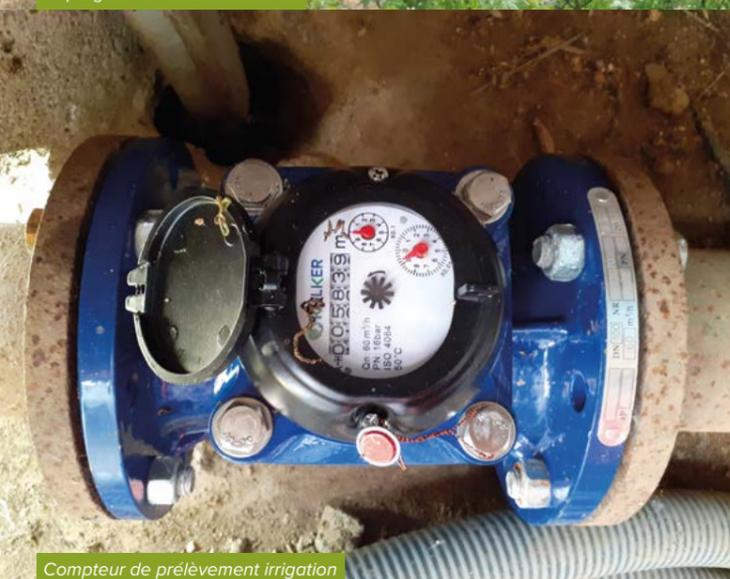
Compteur de prélèvement irrigation
