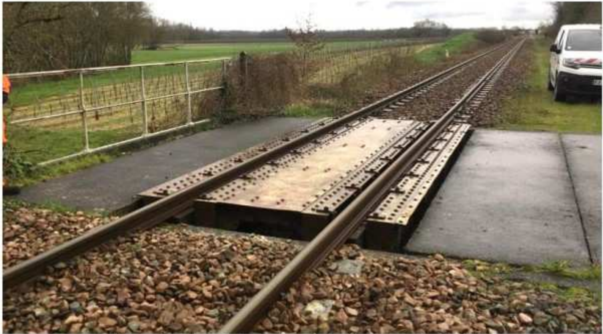
Figure 2 : site actuel avant régénération du pont-rail (PRA)
