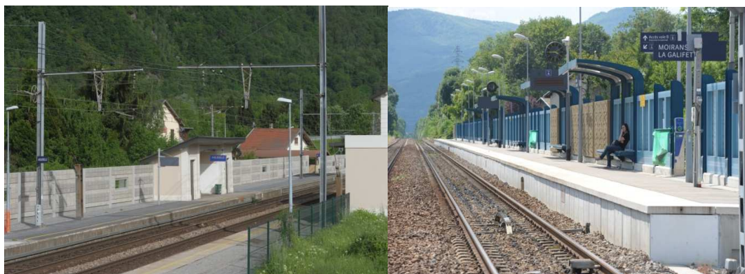
Exemples d'écrans acoustiques à Aiguebelle et Moirans
