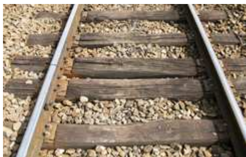
Rails courts sur traverses bois
