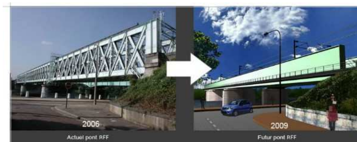
Exemple de changement de pont métallique à Oissel
