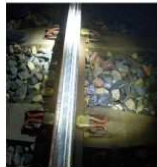
Rail après meulage
