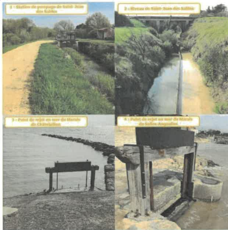
Figure 16 : Photographie des ouvrages constituant la station de pompage de Saint-Jean-des-Sables et des exutoires en mer du Marais de Châtelailon et Sables-Angoulins
